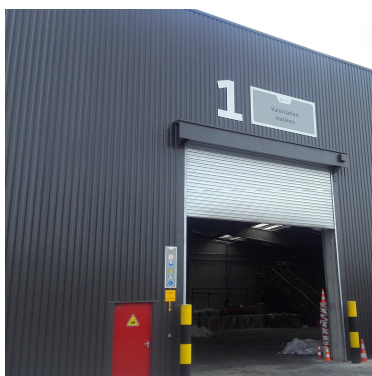
Figure 11 : Vue du bâtiment presse « Valorisation matières »
