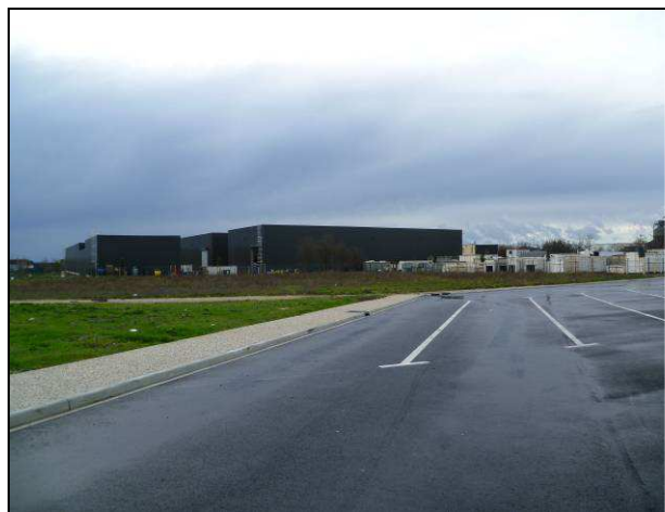
Vue des nouveaux bâtiments du site VEOLIA PROPLETE
