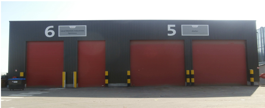
Figure 13 : Vue du bâtiment atelier et du local DD/DASRI
