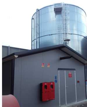
Figure 14 : Vue du local sprinklage
