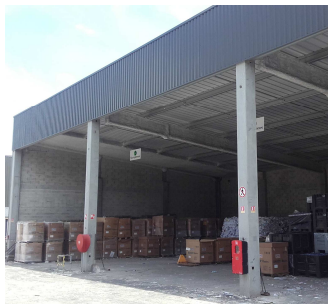
Figure 12 : Vue du bâtiment Stockage de balles
