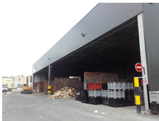
Figure 10 : Vue du bâtiment transfert déchets industriels
